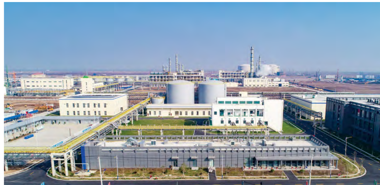
扬农集团位于连云港中化循环经济产业园内的新生产基地
